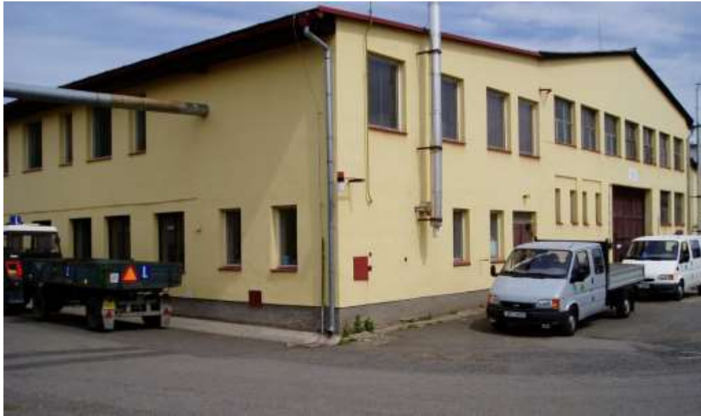
Budovy dílen v hlavním areálu školy v ulici U Kapličky v Sušici.
