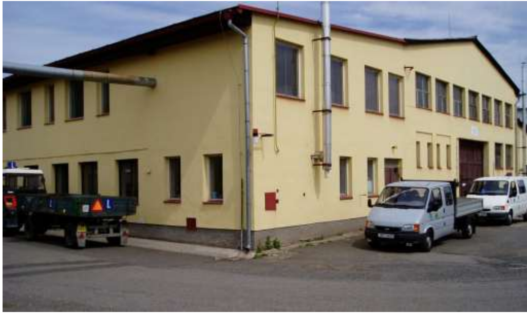
Budovy dílen v hlavním areálu školy v ulici U Kapličky.
